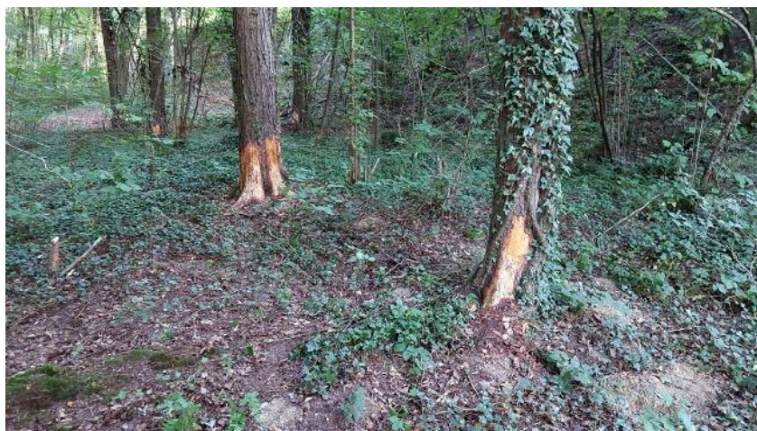
Arbres abîmés en rive droite du Ry d'Ave. Photo : DAMIEN DELVAUX, le 9/08/2024.
